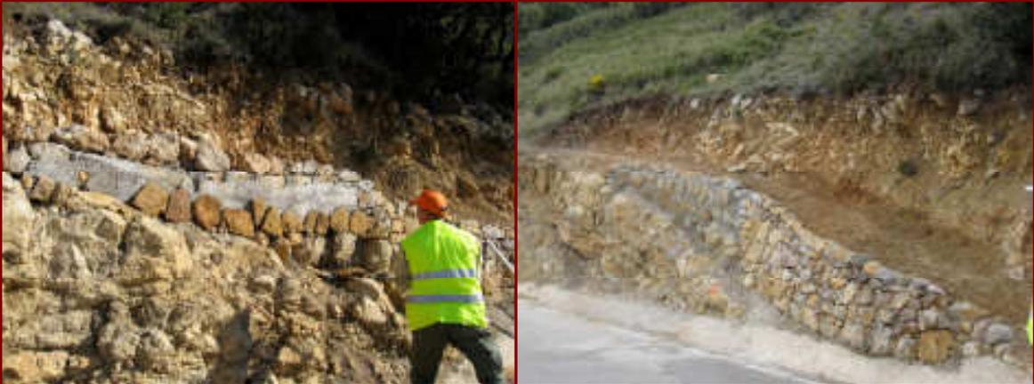
Imagen de uno de un muro de refuerzo construido en la senda de el Convento als Bassiets para asegurar el camino en un tramo peligroso.
