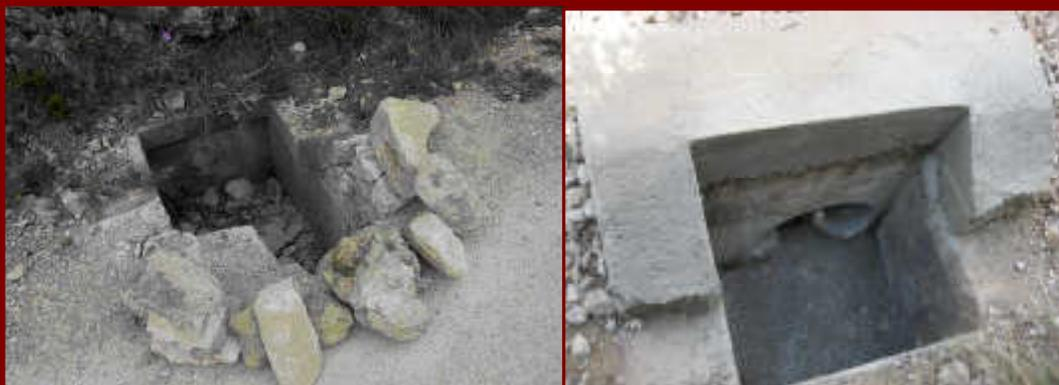
Imagen de los arreglos acometidos en la pista de la Fou para prevenir el riesgo de hundimiento. En la fotografía de la izquierda se aprecia el mal estado en que se encontraba.
