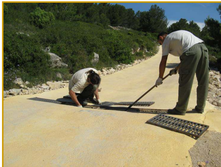
LIMPIEZA CANALIZACIÓN EN PISTA XIVERT
