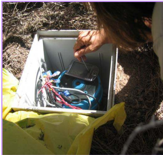
DESCARGA DE DATOS DE LOS CONTADORES AUTOMÁTICOS
