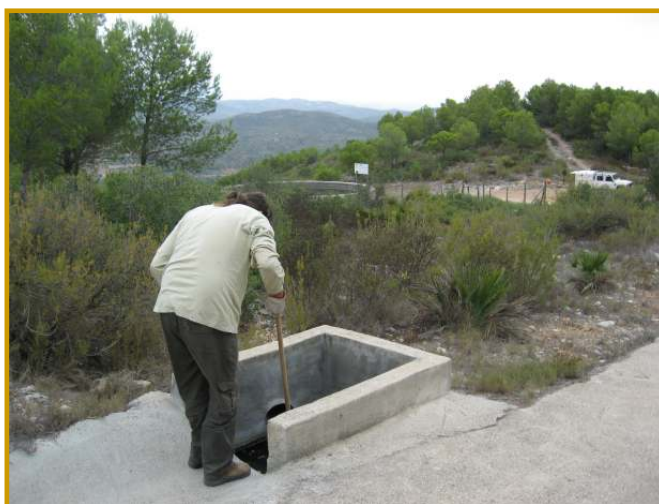
LIMPIEZA ARQUETA EN DEPÓSITO INCENDIOS L'AMETLER
