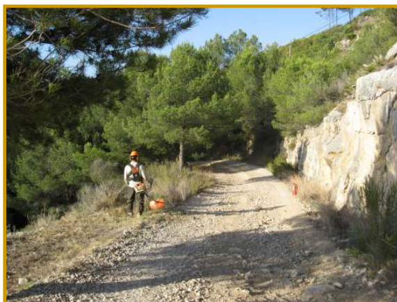
DESBROCE PISTA ACCESO TORRE EBRI
