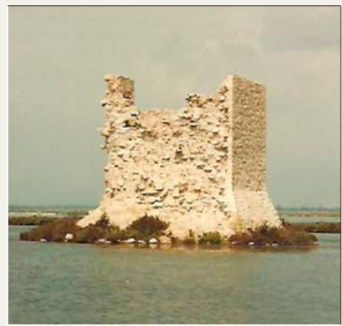
Antes de su restauración.
