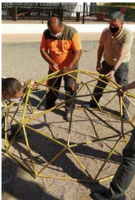
ILUSTRACIÓN 37: CONSTRUCCIÓN DOMO GEODÉSICO CON CAÑA
