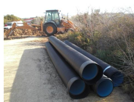
ILUSTRACIÓN 23, 24, 25 Y 26: TRABAJOS DE CAPTACIÓN DE AGUAS
