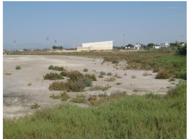
ILUSTRACIÓN 16 Y 17: ESTADO ACTUAL DE LAS CHARCAS DE MÚRTULAS
