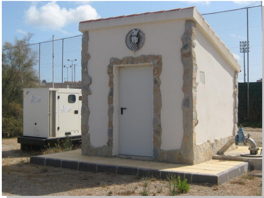
ILUSTRACIÓN 9: MOTOR DE AGUA Y GRUPO ELECTRÓGENO
