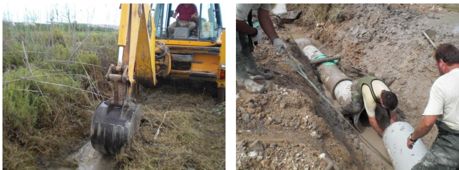
ILUSTRACIÓN 18 Y 19: APERTURA DE ZANJA Y SUSTITUCIÓN DE TUBERÍAS
