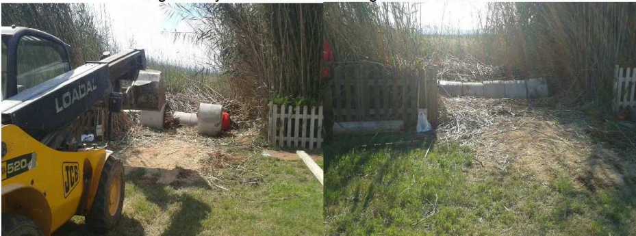
Figuras 3 y 4 retro colocando tubería para que pueda pasar el tractor con las gavias
