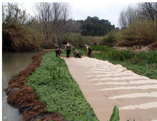
Colocación de manta biodegradable en el segundo foco de M. aquaticum.
