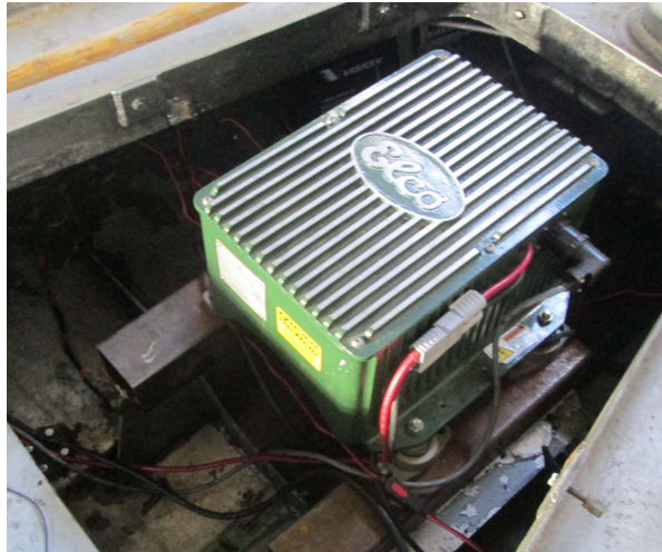
Instal·lació de motor elèctric
