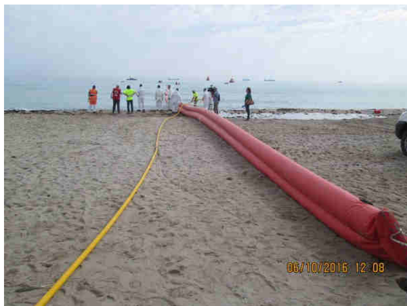
Muntatge de sistemes d'extracció
