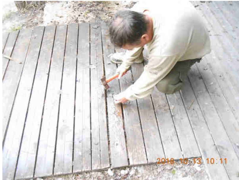
Reparació de passarel·les a l'ullal de Baldoví, terme de Sueca
