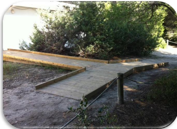
Fotografía 27: Pasarela nueva en la salida del Centro de Visitantes
