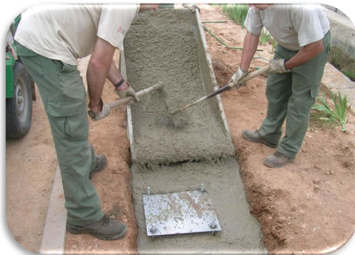
Fotografía 23: Colocación de anclajes para las nuevas marquesinas en el mes de mayo
