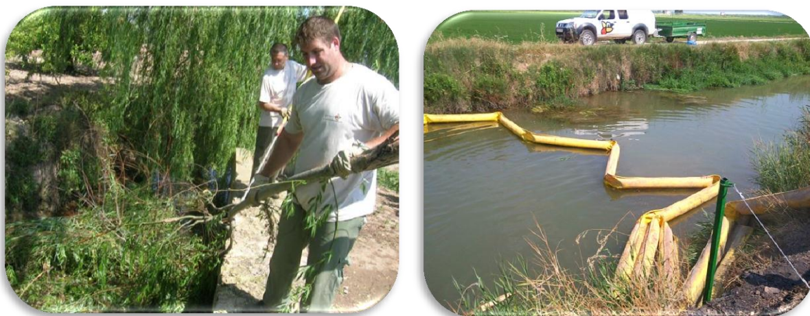
Fotografía 12: Trabajos de mantenimiento de la Brigada
