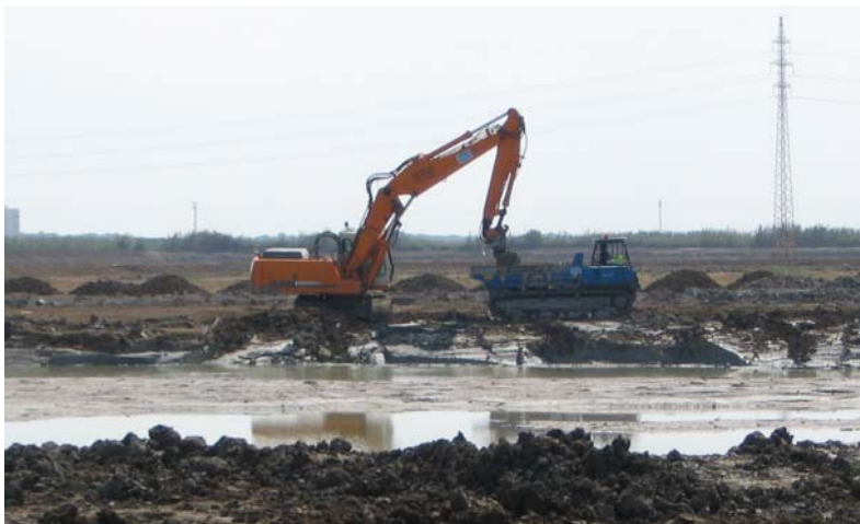
Maquinaria trabajando en el Tancat de la Pipa.
