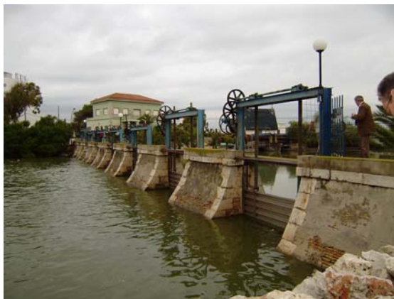
Compuertas del Perellonet.
