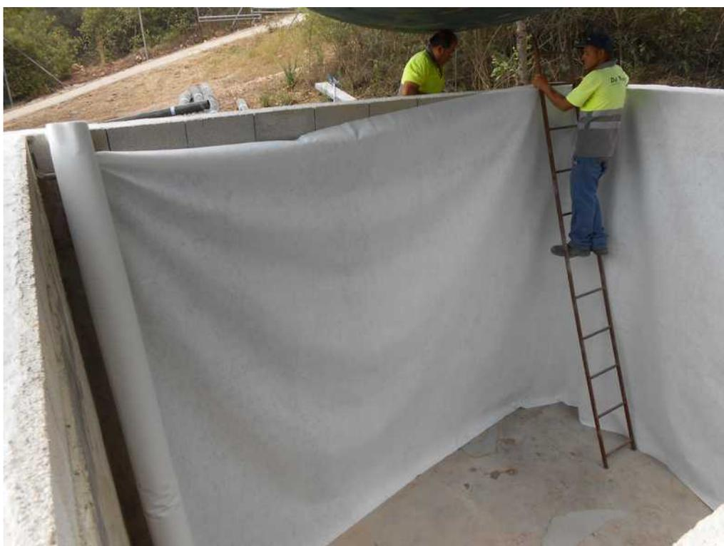
Trabajos de mejora y revestimiento de la balsa del vivero forestal para el almacenado de las aguas sobrantes de la depuradora.
