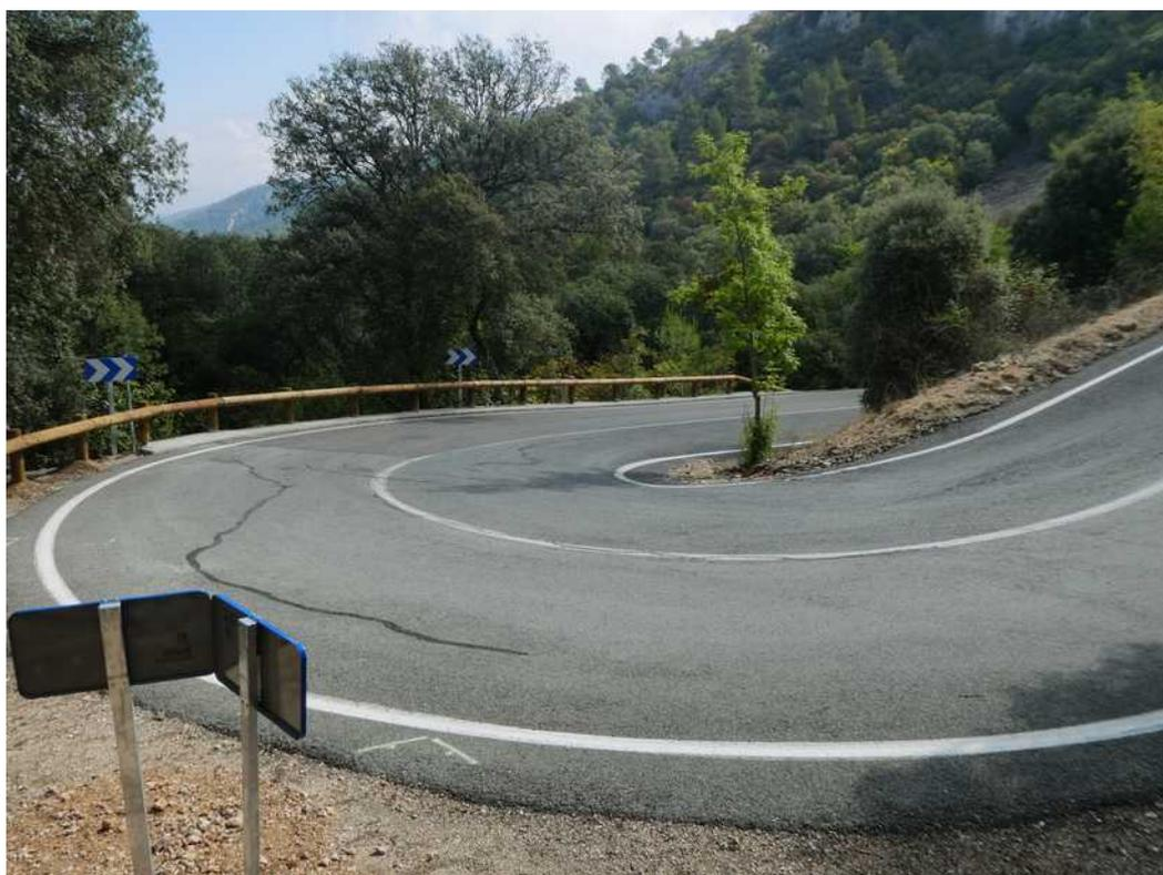
Tramo de barandilla revestida de madera en curvas con peligro de accidente y reposición de señales verticales
