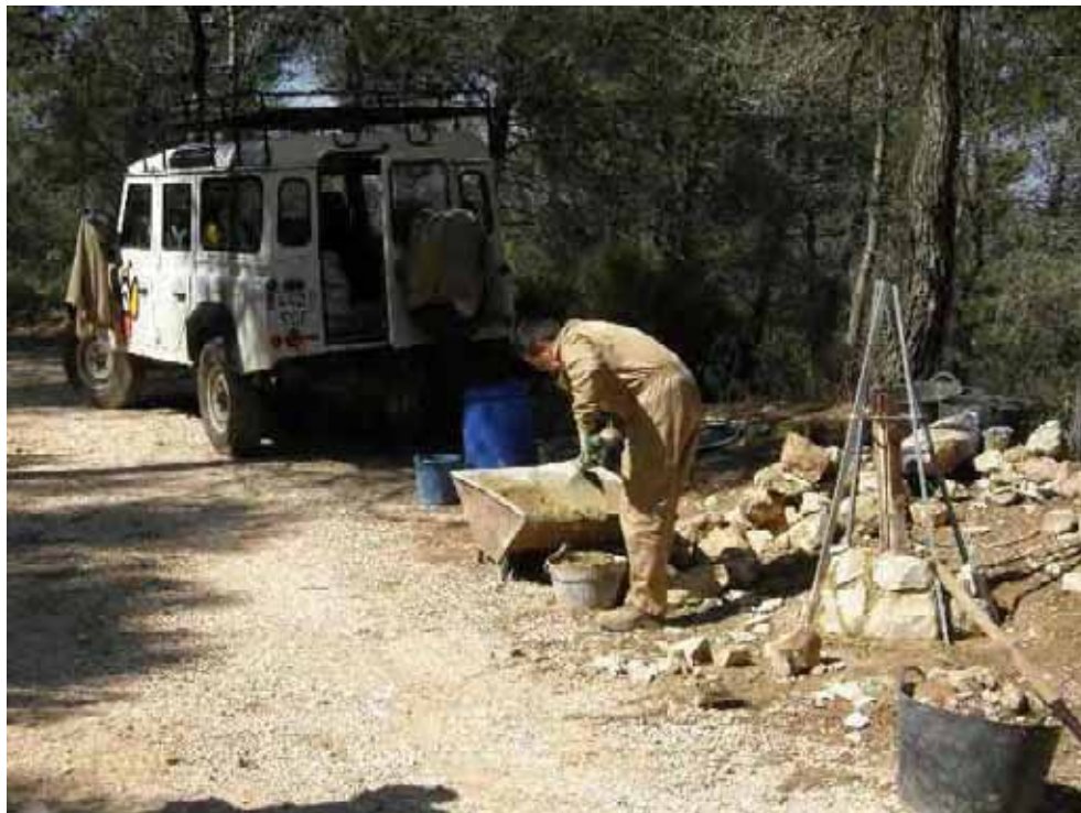
Imagen 54. Construcción de pilones para la instalación de una cadena de cierre de camino de acceso al Parque Natural. Fuente: Parque Natural Font Roja.
