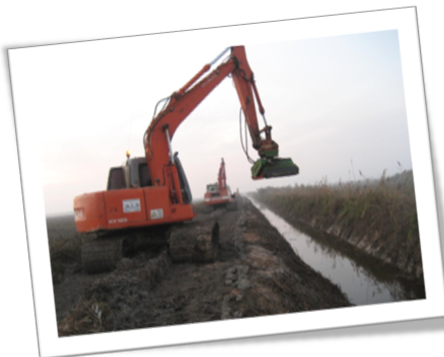
ILUSTRACIÓN 11: OBRAS DE ACONDICIONAMIENTO EN LA RESERVA
