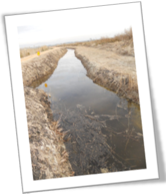
ILUSTRACIÓN 10: ZANJÓN PERIMETRAL TRAS SU LIMPIEZA
