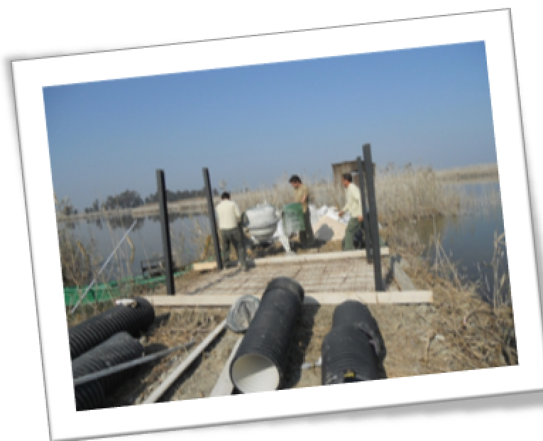
ILUSTRACIÓN 13: OBRAS DE CONSTRUCCIÓN DEL NUEVO OBSERVATORIO
