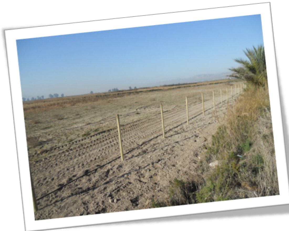
ILUSTRACIÓN 3: INSTALACIÓN DE VALLA CINEGÉTICA
